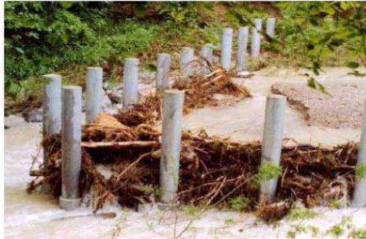
Figure 164: Inverted V Trash Rails « Peigne à embâcle »
